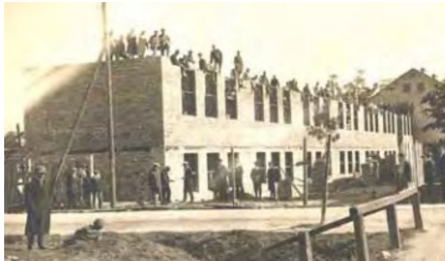
Budowa nowego gmachu szkół powszechnych, ok. 1930 r.
